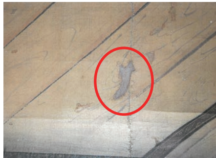
⑤ 床板○部分：欠損箇所に異質の補彩
