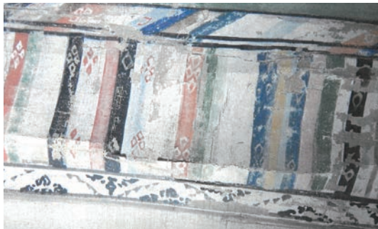
④ 畳の縁：横折れが発生し、絵具の剥落が著しい
